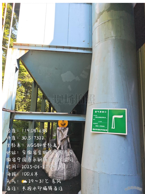
图 6.1-1 熔化、球化、造型及浇注废气处理设施及废气排放口（DA001）
