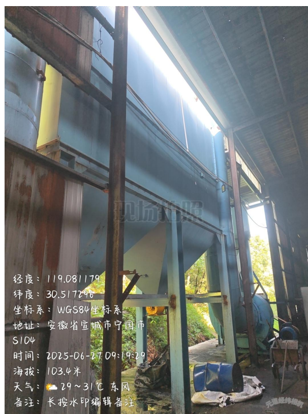
图 6.1-1 熔化、球化、造型及浇注废气处理设施及废气排放口（DA001）
