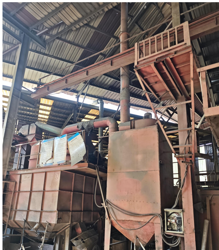
图 6.1-8 钢球车间砂处理废气排气筒（DA008）
