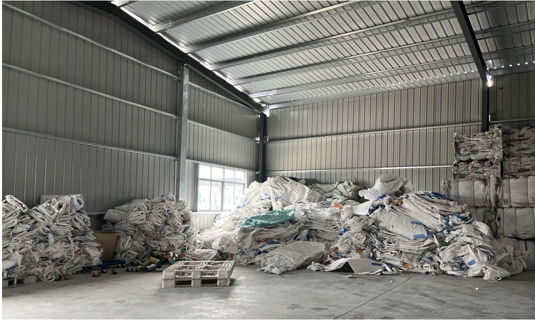
图 6-3 一般固废暂存间
