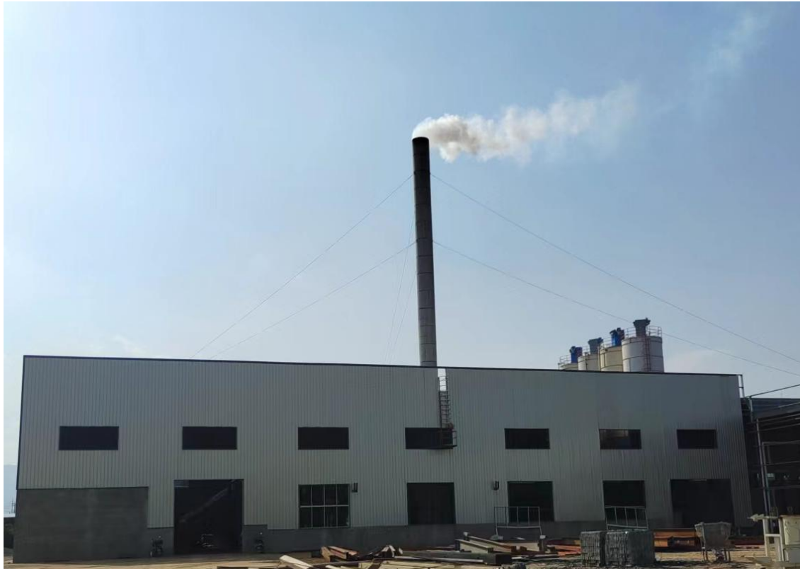
图 5-1 锅炉废气排气筒 (DA003)
