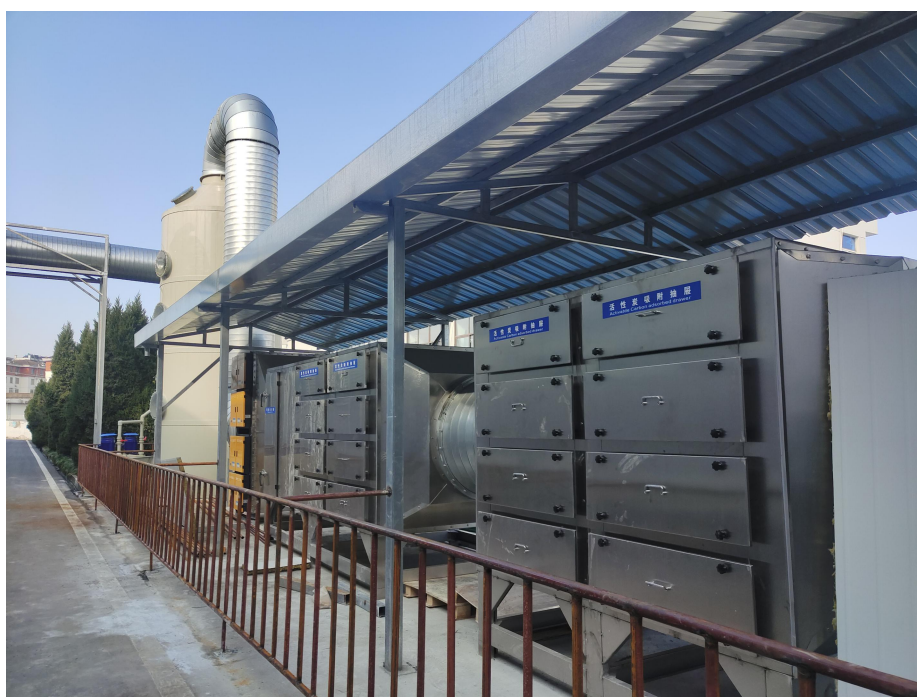
图 6-2 喷淋塔+工业油烟净化器+二级活性炭吸附箱
