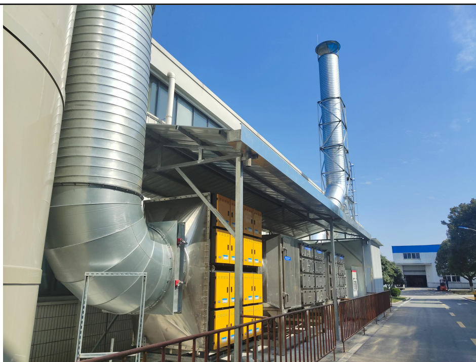
图 6-3 喷淋塔+工业油烟净化器+二级活性炭吸附箱
