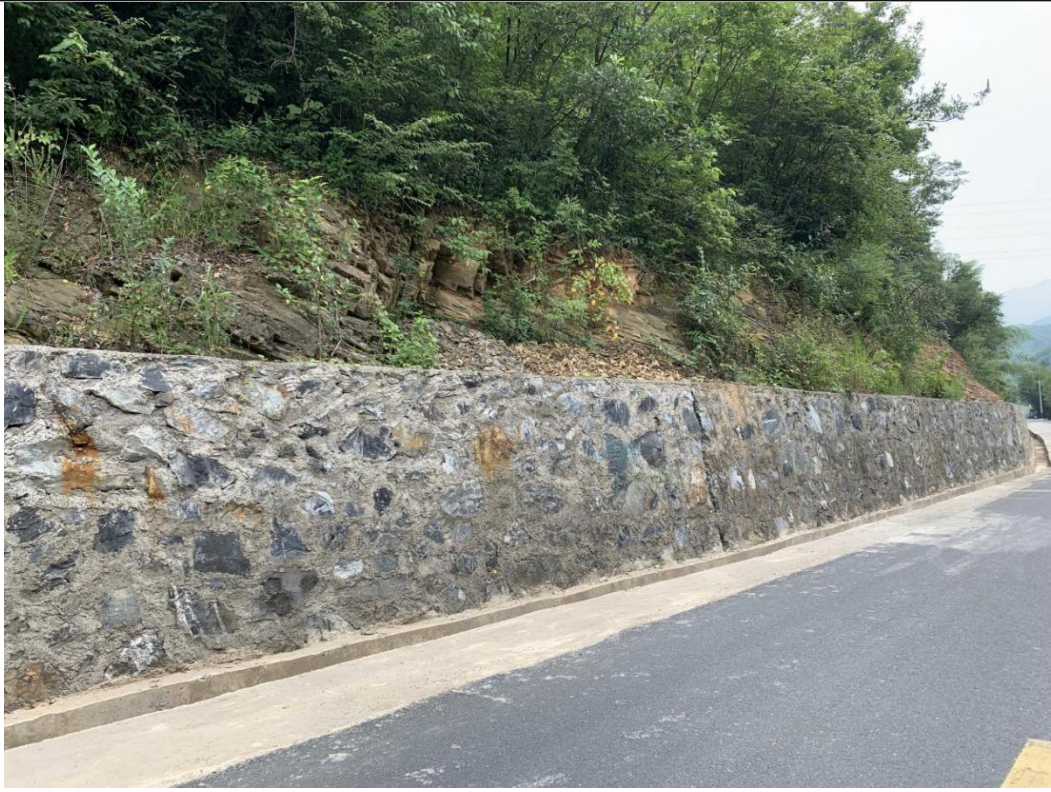
图 6-3 边坡防护工程
