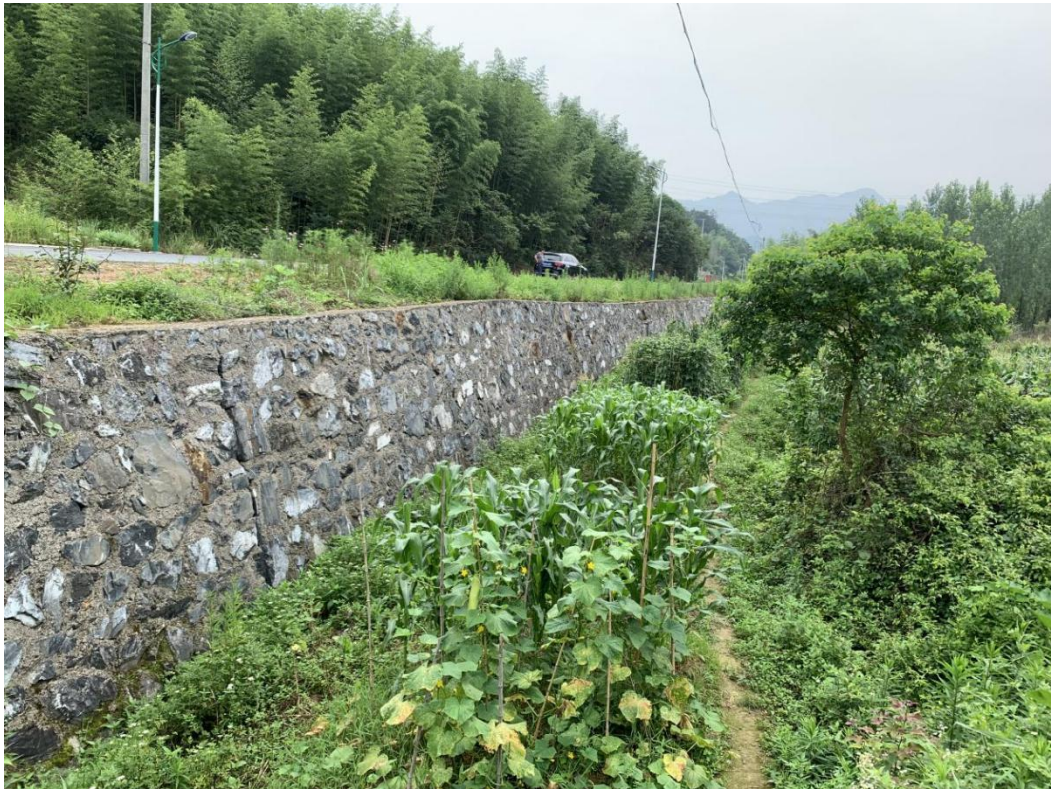
图 6-4 边坡防护工程
