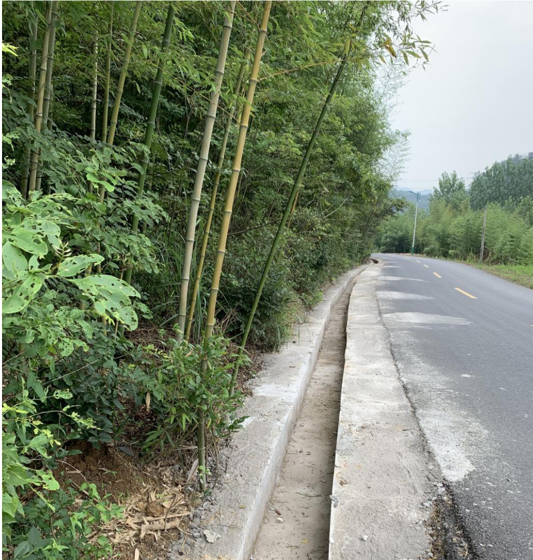
图 6-1 路面排水工程
